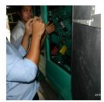
generator, ศูนย์เวเวร์, เครื่องปั่นไฟไฟฟ้า
