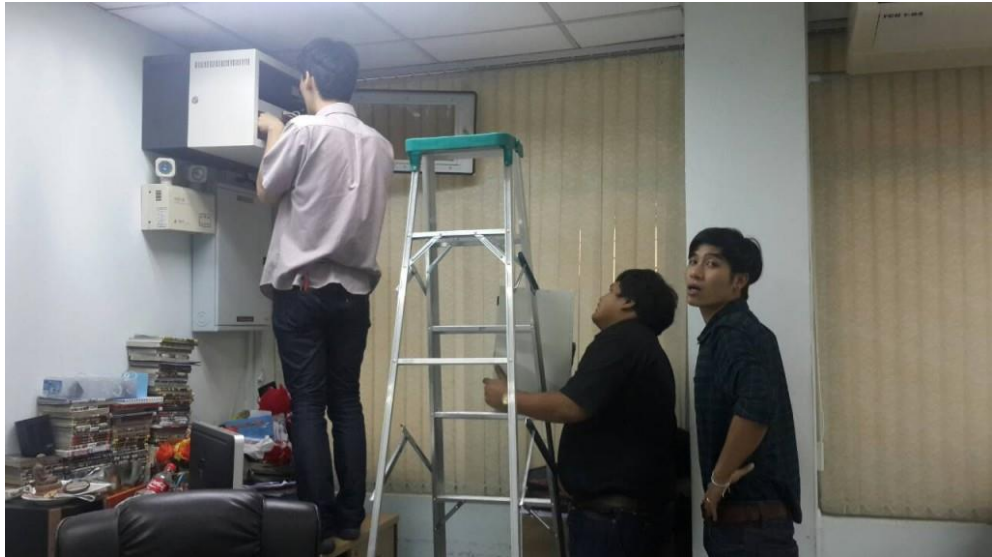
ติดตั้ง OmniSwitch 6900 ศูนย์เทเวศร์
