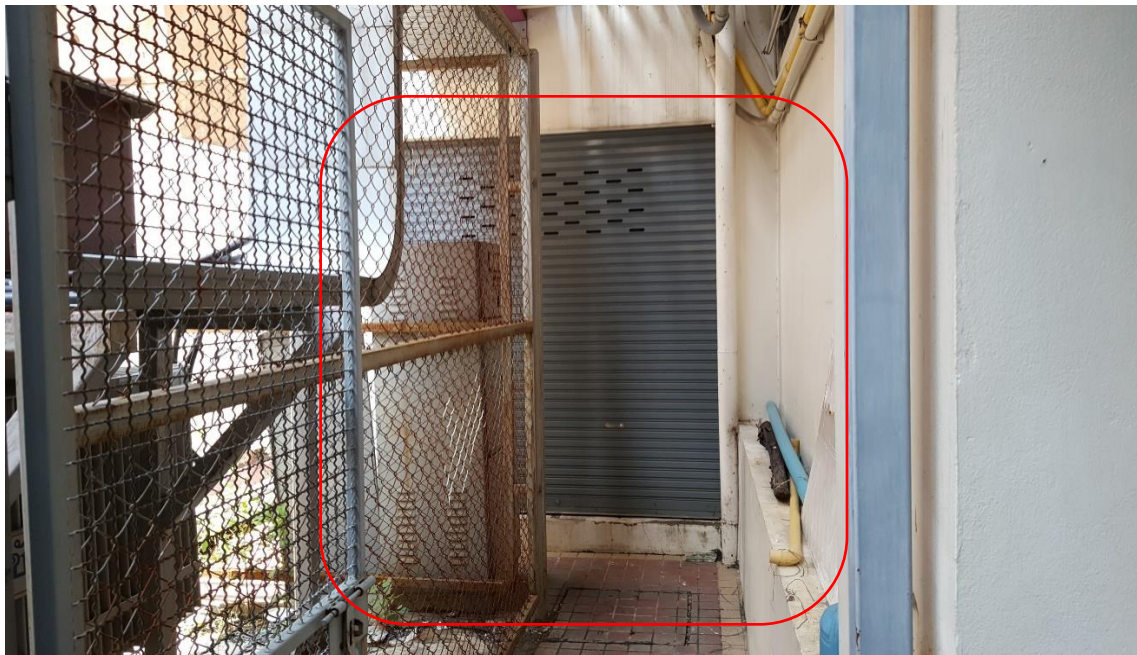
ในห้องไฟฟ้า ด้านหลังตึก
