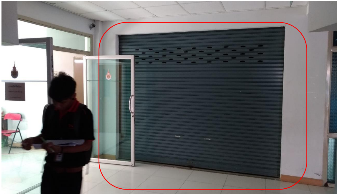
ในห้องควบคุมไฟฟ้า
