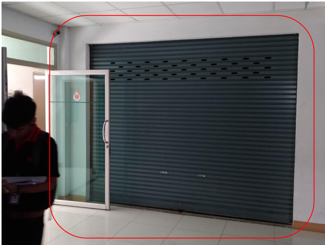
ในห้องเครื่องไฟฟ้า
