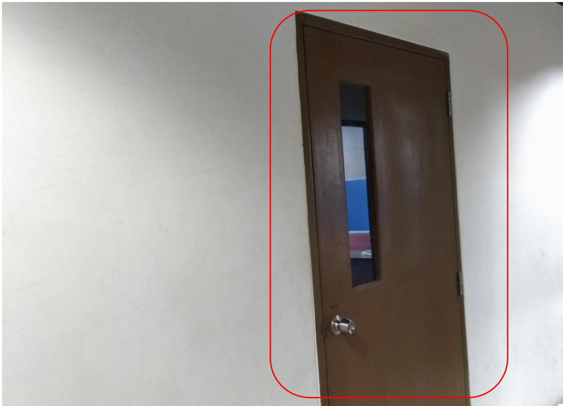
ในห้องไฟฟ้า
