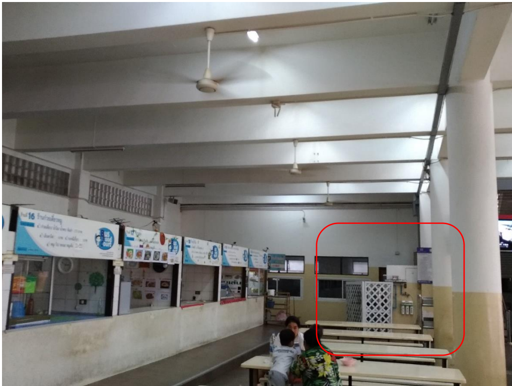
ข้างห้องล้างภาชนะ
